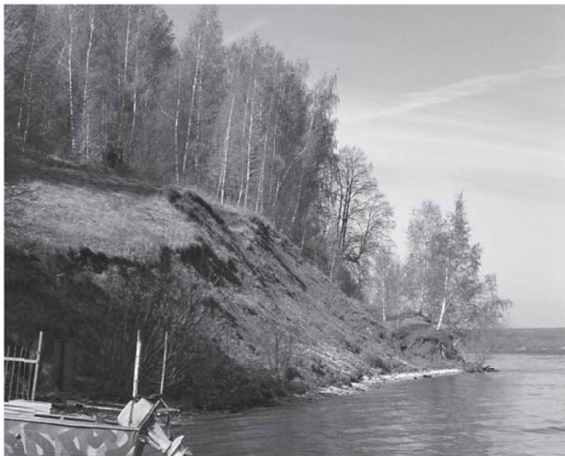
Рис. 1. Оползневые деформации на участках берега Чебоксарского водохранилища выше г. Чебоксары, не защищенных конрабанкетом.
